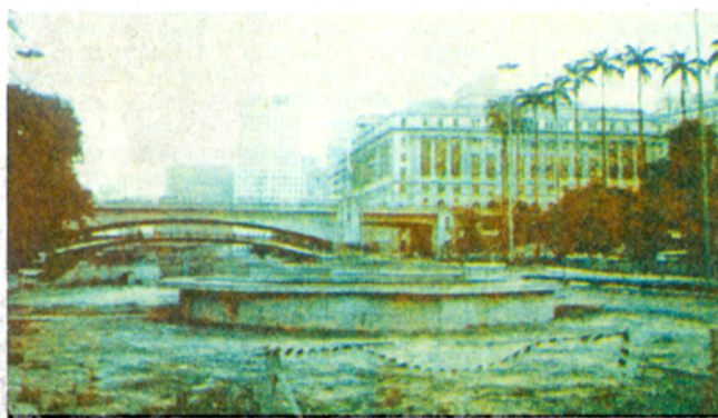
Vista das obras de reurbanização do vale do Anhangabaú, em SP
